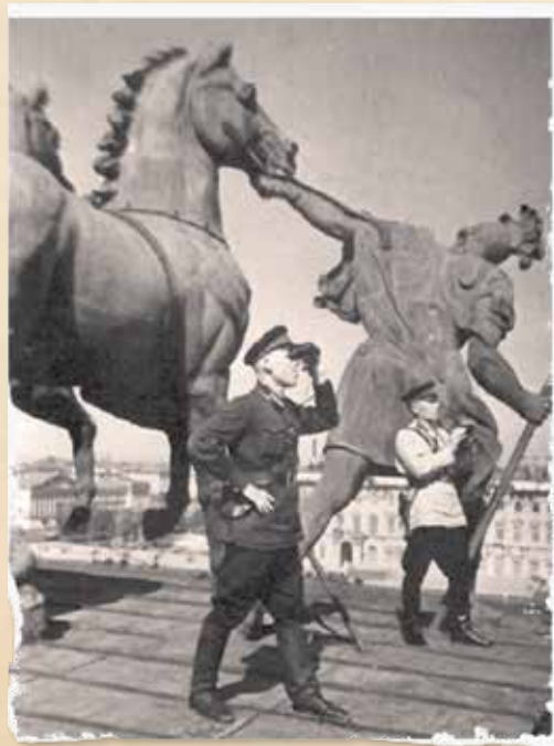
Дежурство на крыше здания Главного штаба
