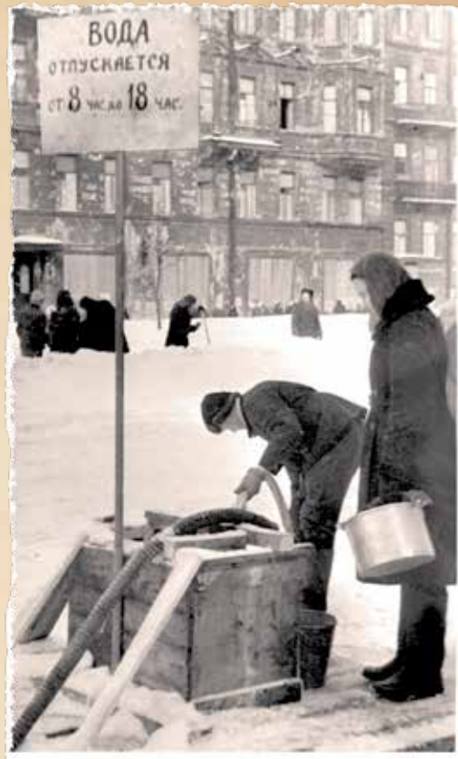
Водозаборная колонка на Лиговском проспекте
